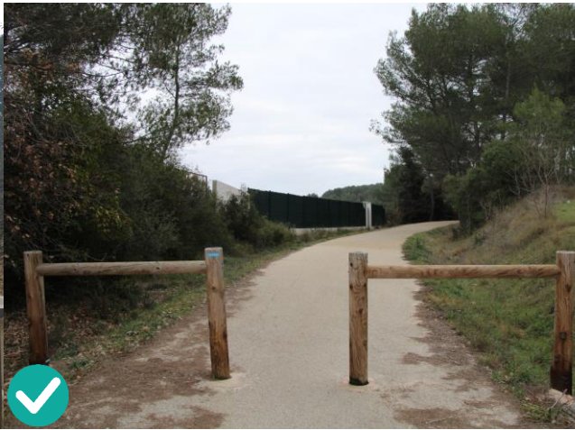
Voie verte – anciennes voies ferrées -> qualité aménagement mais attention à la largeur entre les barrières
