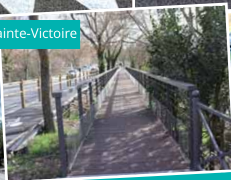
■ Requalification de l'avenue du 8 mai avec création d'une passerelle pour sécuriser le cheminement piéton
