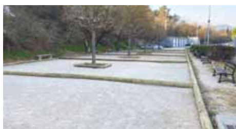
■ Réhabilitation des terrains de pétanque à côté de la gare routière
