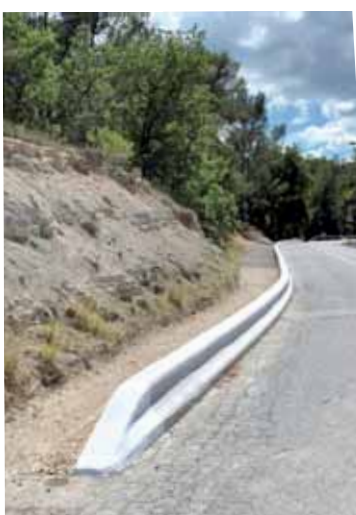
■ Mise en sécurité du cheminement piétons et réfection des trottoirs sur le chemin des Vertus
