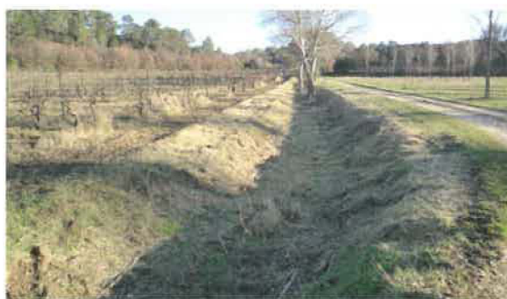
Une noue de récupération des eaux.
