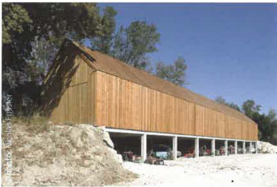
À Avignon (84), ce hangar utilise la topographie pour dissimuler le stockage des engins. (Unic Architecture.)
