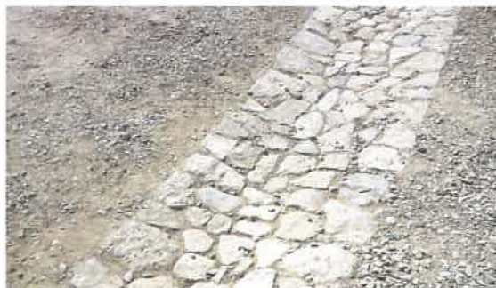
Un calepinage de pierres sert de cantiveau.
