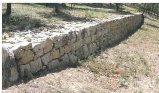
Une restanque en pierre sèche ralentit l'eau de ruissellement, utilise des matériaux locaux et favorise la biodiversité.
