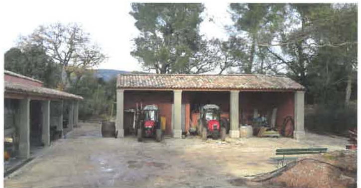
Ce hangar est dimensionné correctement pour abriter les engins agricoles (ici à Puyloubier).
